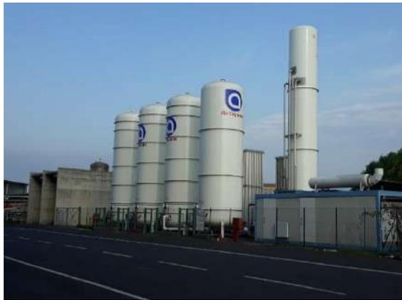
La produzione di idrogeno, è assicurata da un impianto che converte gas naturale e vapore acque in Idrogeno.
